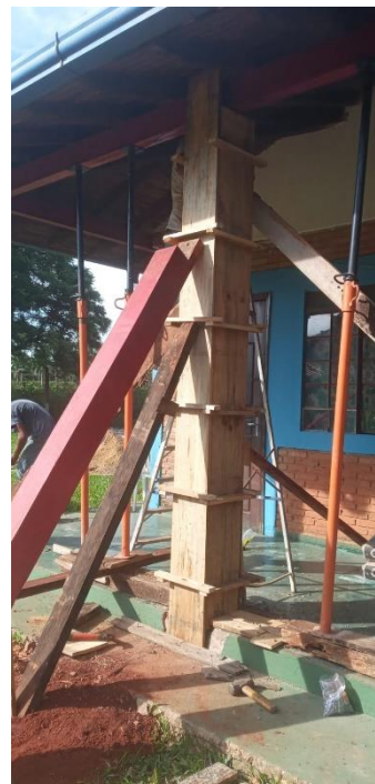
Nå er det betong.
